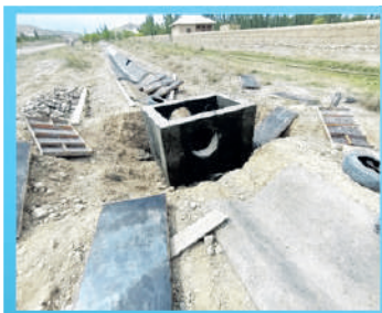
Умай-Эне айылына 500 метр бетон арык курулду
